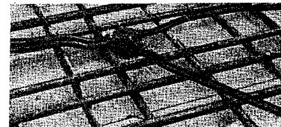
Fig. 4. Stålør og dase til indstøbning i jernbeton.
