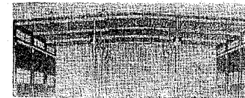
Fig. 17. Svensk konstruktion udført i strengbeton.
